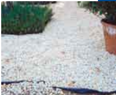
Géotextile sous les gravillons
